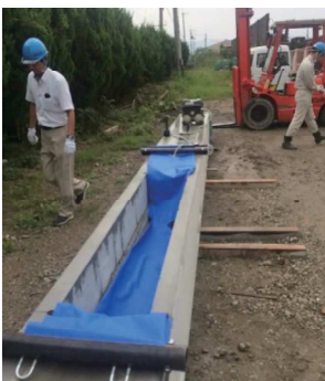
チューブ型枠の設置
