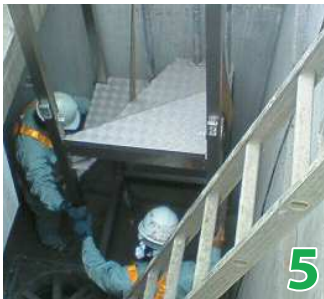
階段搬入及び設置
