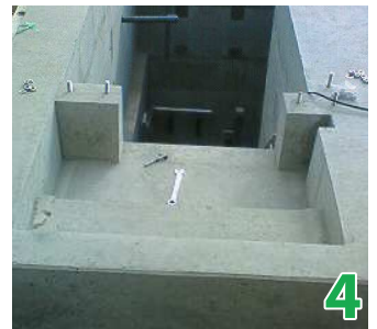
固定金具取付
