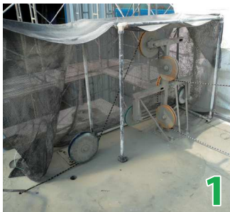
ワイヤーソーによる切削
