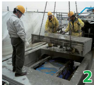
人道BOX 頂版部分切削 ブロック撤去
