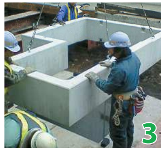
土留めブロック裾付け
