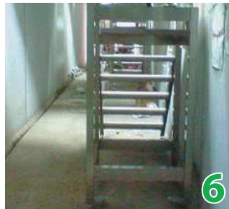
階段設置完了
