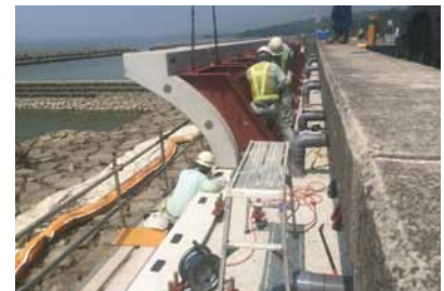
⑥ ブロック据付
