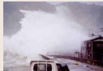
従来の護岸形式での被害状況
