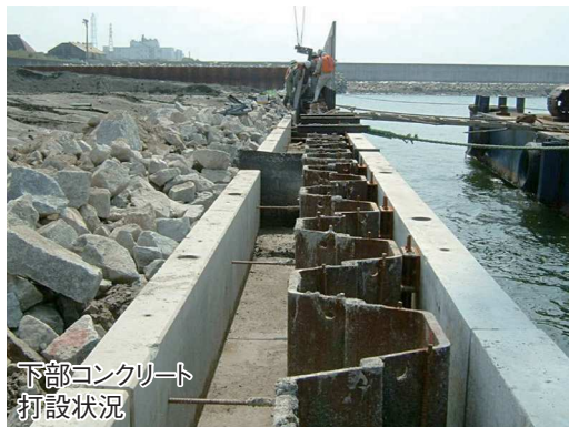
陸側設置状況 (Aピース設置)
