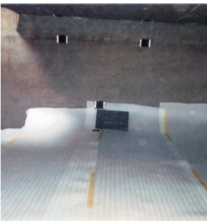
5 緩衝シートを貼付け
