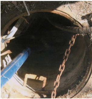
1 水槽内の水の汲み出し
