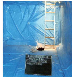
7 リーブシート貼付け完了
